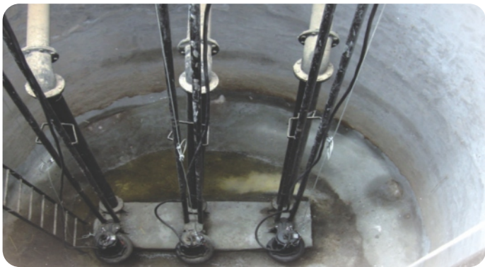
Figura 12.39 – Esgotamento de sapatas de construção
