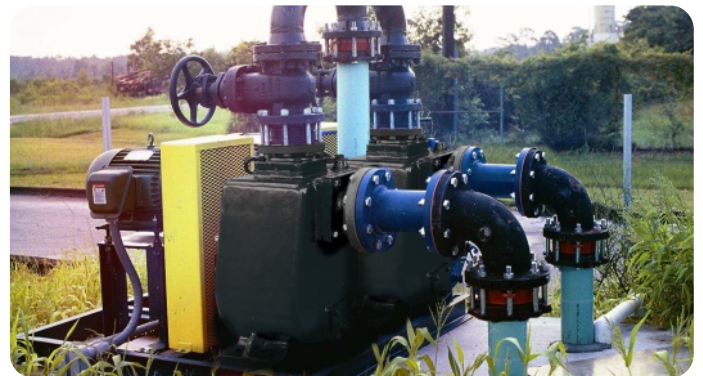
Figura 12.36 – Bombeamento de esgoto com motobombas de superfície
