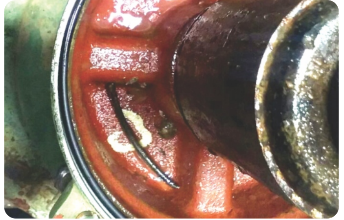
Figura 13.11 – Presença de água no rotor do motor
