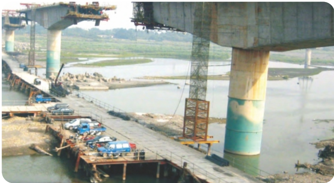
Figura 12.37 – Rebaixamento de lençol freático
