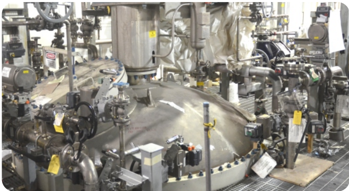
Figura 12.14 – Bombeamento de produtos químicos
