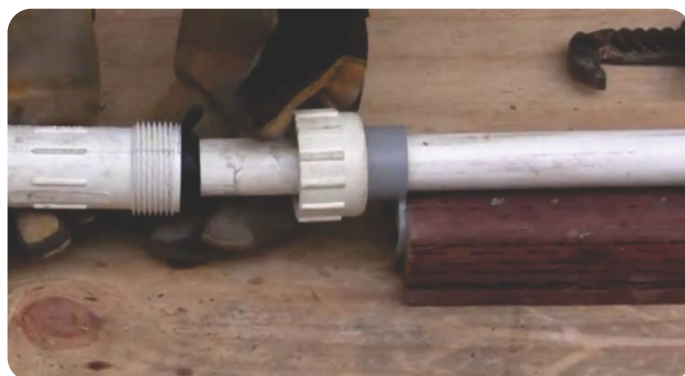
Figura 13.22 – Redução da bitola da tubulação
