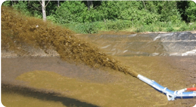
Figura 12.24 – Bombeamento de chorume
